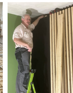
Lydpaneler sættes op
