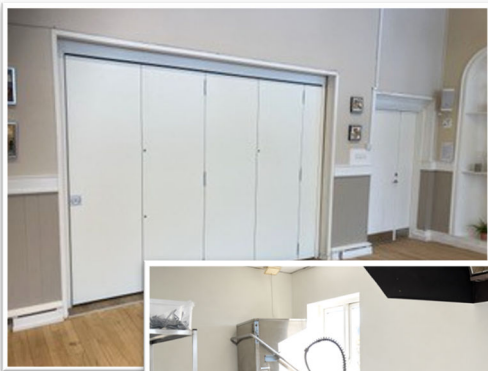
Renoveringen indebar også, at vi fik nye foldedøre
