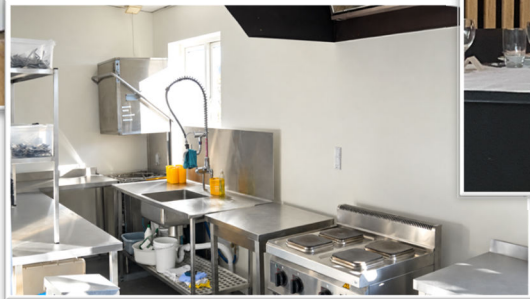
Nyt køkken, der blev etableret i forbindelse med renoveringen
